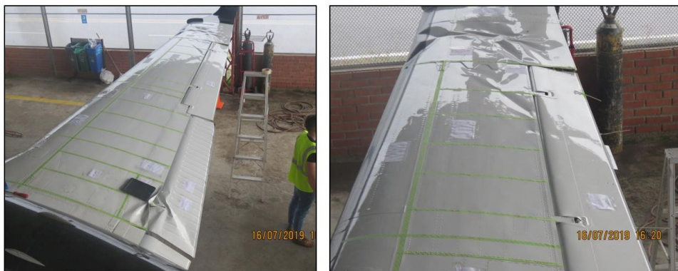
Fotos No. 4 y 5 Mapeo de daños estructurales plano derecho
